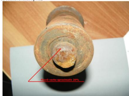
Fig.10. Bulonul de fixare a urechii corpului regulatorului automat de timonerie tip RL2-350 de pârghia timoneriei de frână – prezentare fisură.
