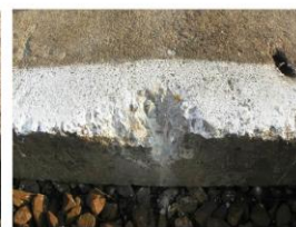
Fig.6 Prima dală a pasajului de trecere pietonal de la km 285+950 lovită.
