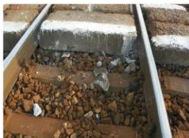
Fig.7 prima dală a pasajului de trecere pietonal de la km 285+850 lovită.
