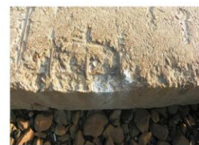
Fig.5 Prima dală a pasajului de trecere pietonal de la km 286+080 lovită.
